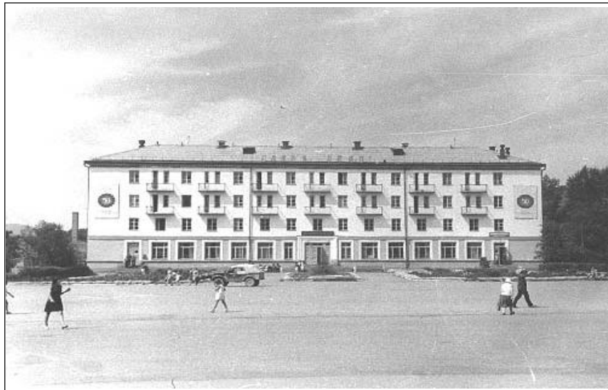
Здание гостиницы органично вписывается в архитектурный облик центральной площади города
