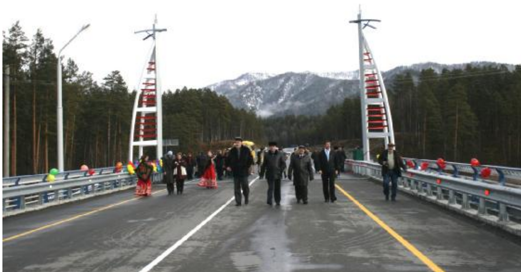
Новый устьсеминский мост открыт в ноябре 2010 года
