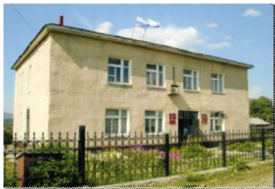
Новое здание Чойского районного суда
