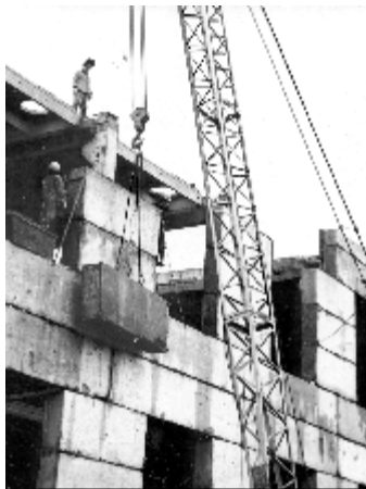
Продукция завода железобетонных изделий – бетонные блоки – широко использовалась на стройках города. Идёт строительство административного здания швейной фабрики. Фотография 1981 года
