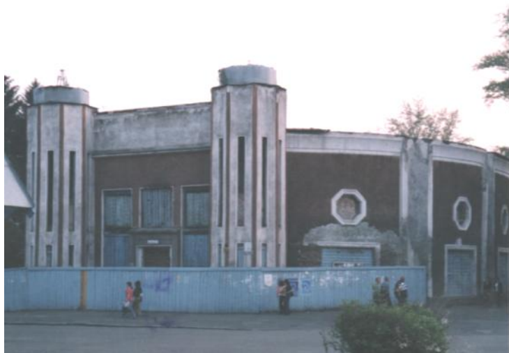
Здание кинотеатра им. М. Горького после пожара 1994г.
